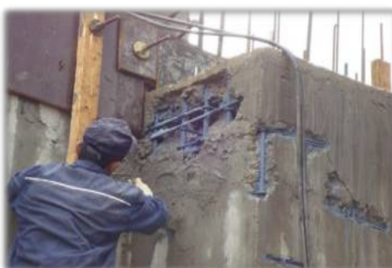
Рисунок 7 - Ремонт мостовых опор материалами «АКВАТРОН»
