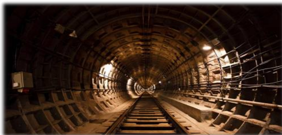
Рисунок 4 - Ремонт тоннеля Бакинского метрополитена
