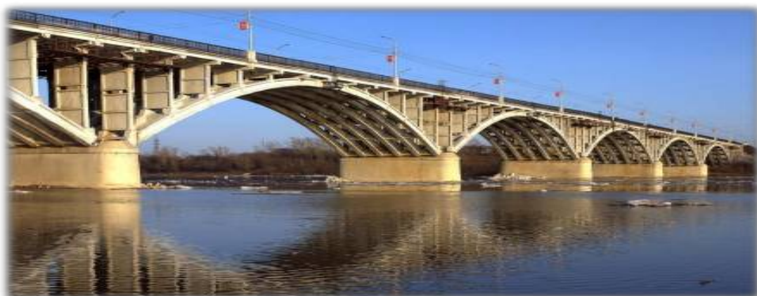
Рисунок 1 - Ремонт коммунального моста г. Бийска (бетон + 0,5 % «АКВАТРОН-12»)
