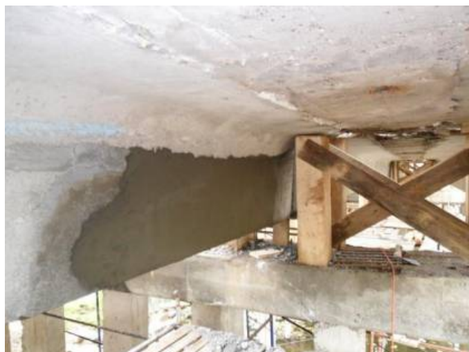
Рисунок 8 - Ремонт мостового перехода материалами «АКВАТРОН»
