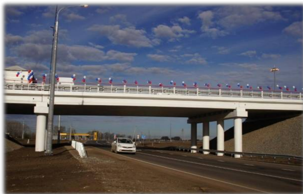
Рисунок 2 - Ремонт обьездного моста г. Бийска (бетон + 0,5 % «АКВАТРОН-12»)
