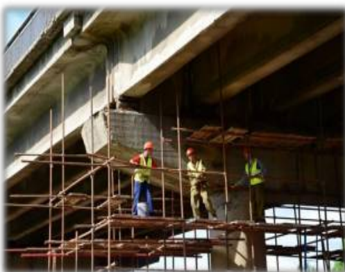
Рисунок 7 - Ремонт мостовых опор материалами «АКВАТРОН»
