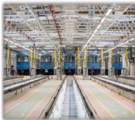
Рисунок 6 - Ремонт электродепо «Митино» Московского метрополитена
