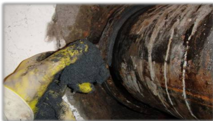
Рисунок 9 - Герметизация вводов коммуникаций материалом «АКВАТРОН-6Ш» шовный
