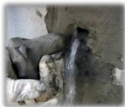
Рисунок 3 - Заделка напорной (активной) течи материалом «АКВАТРОН-8Б»
