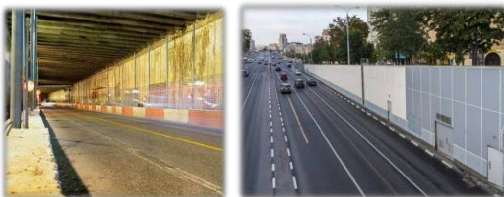
Рисунок 5 - Ремонт Таганского транспортного тоннеля в г. Москве
