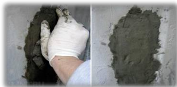
Рисунок 5 - Пример ремонта материалом «АКВАТРОН-8П»
