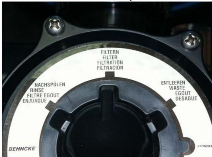
**В режиме промывки** фильтра схема движения воды выглядит следующим образом: вода из ванны подается насосом фильтровальной установки в фильтр, далее проходит обратным потоком через фильтр (снизу вверх) и сбрасывается в канализацию. При промывке фильтра, для избежания завоздушивания и выхода из строя (поломки) насоса, забор воды
