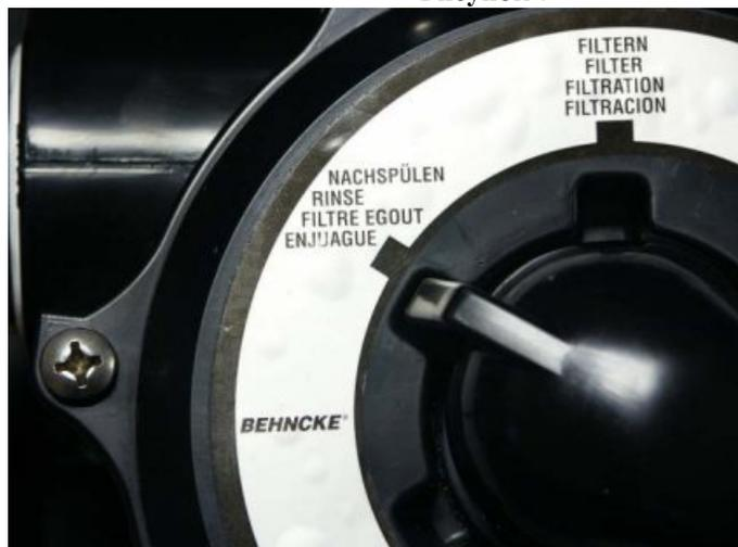
**В режиме опорожнения** схема движения воды выглядит следующим образом: вода из ванны забирается насосом фильтровальной установки, минуя фильтр, сбрасывается в канализацию. В режиме опорожнения положение ручки вентиля показано на рисунке 8.
