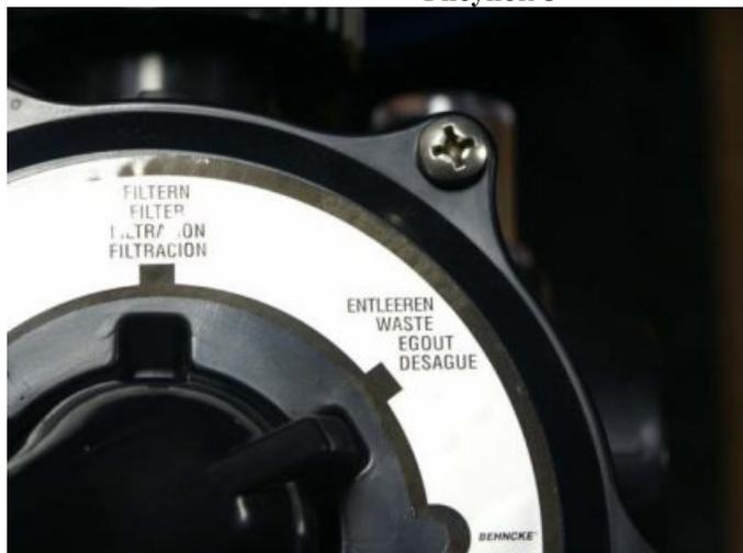
В режиме рециркуляции схема движения воды выглядит следующим образом: вода из ванны забирается насосом фильтровальной установки, минуя фильтр, возвращается в бассейн. В режиме рециркуляции положение ручки вентиля показано на рисунке 9.
