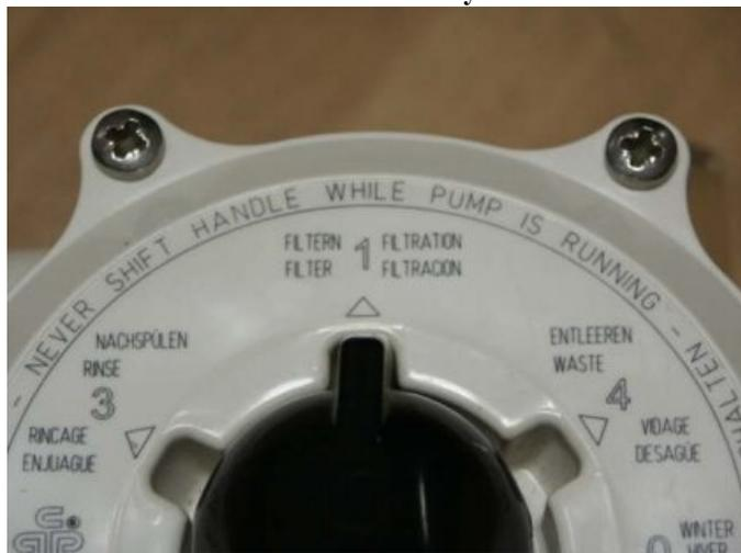
**В режиме промывки** фильтра схема движения воды выглядит следующим образом: вода из ванны подается насосом в фильтр, далее проходит обратным потоком через фильтр (снизу вверх) и сбрасывается в канализацию. При промывке фильтра, для избежания завоздушивания и выхода из строя (поломки) насоса, забор воды рекомендуется осуществлять через донные сливы ванны бассейна. В режиме промывки фильтра положение ручки вентиля показано на рисунке 6.
