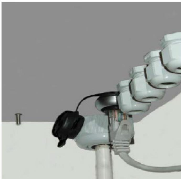
Подключите кабель Cat5 к черному разъему (RJ45) на нижней стороне корпуса парогенератора.
