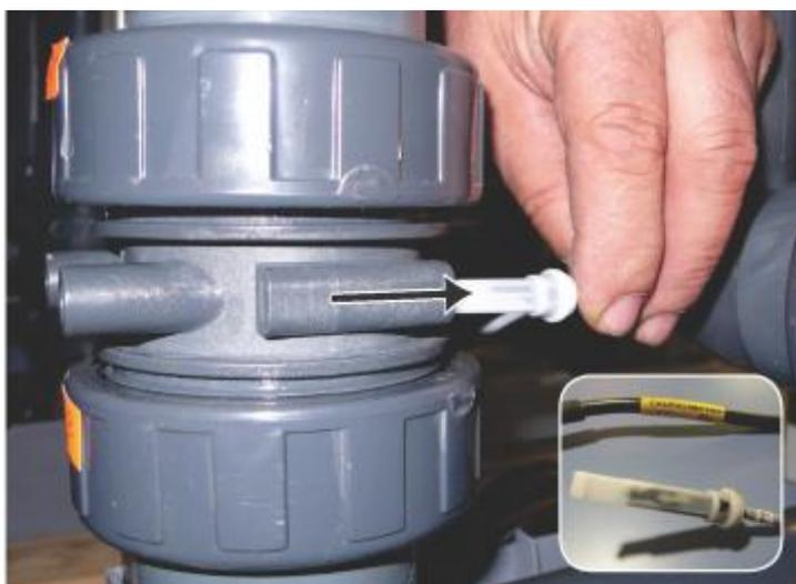
Рисунок 169: Датчик потока
