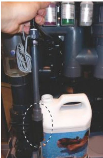
Рисунок 167: Фильтр тонкой очистки
