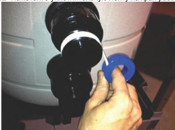
Рисунок 45: Намотка уплотнительной ленты
