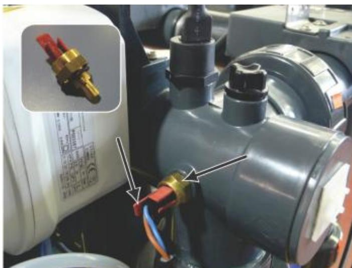
Рисунок 163: Датчик температуры
