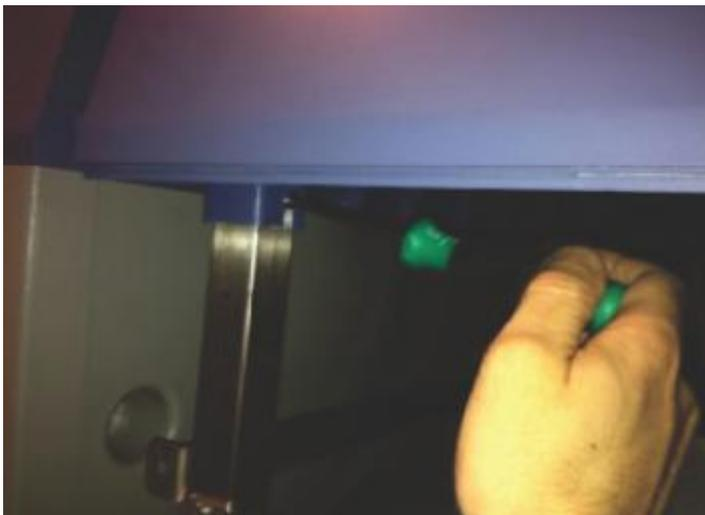
Рисунок 32: Отвинчивание одного из четырех винтов на раме фильтрационного модуля
