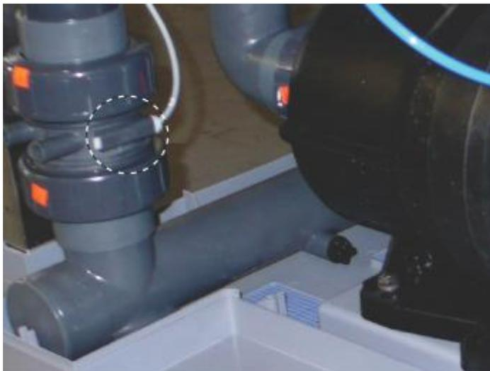
Рисунок 168: Расположение датчика потока
