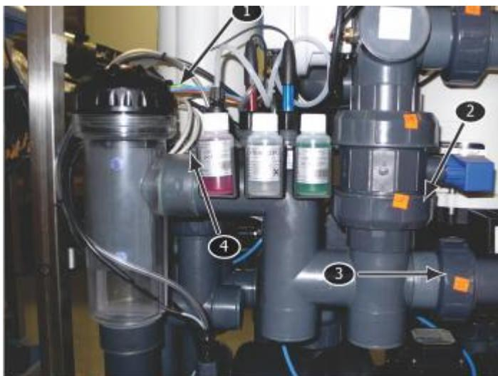
Рисунок 193: Извлечение солевого хлоратора
