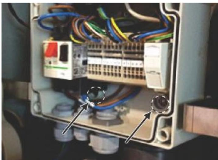
Рисунок 204: Снимите два крепежных винта электрической коробки
