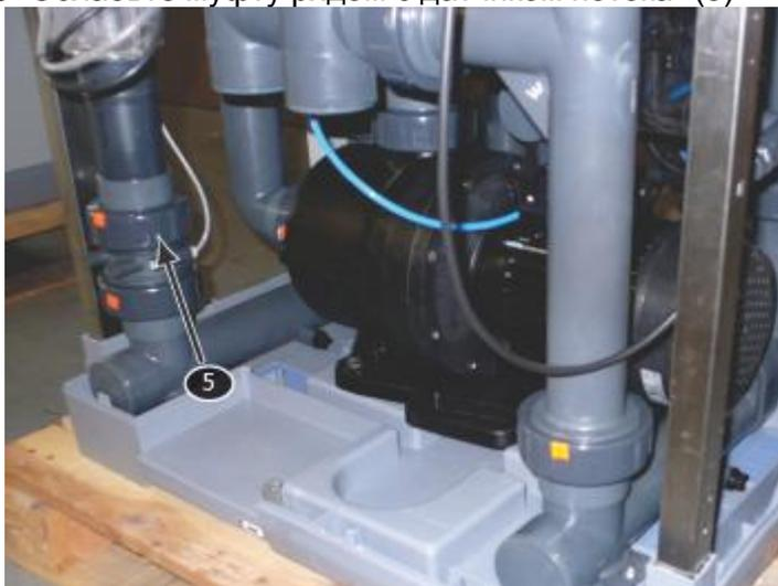
Рисунок 194: Извлечение солевого хлоратора
