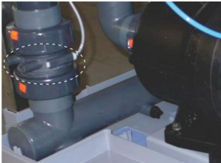
Рисунок 170: Расположение турбины датчика потока
