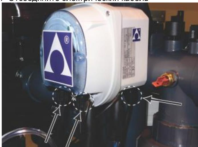
Рисунок 185: Пластиковые трубки и электрический кабель
