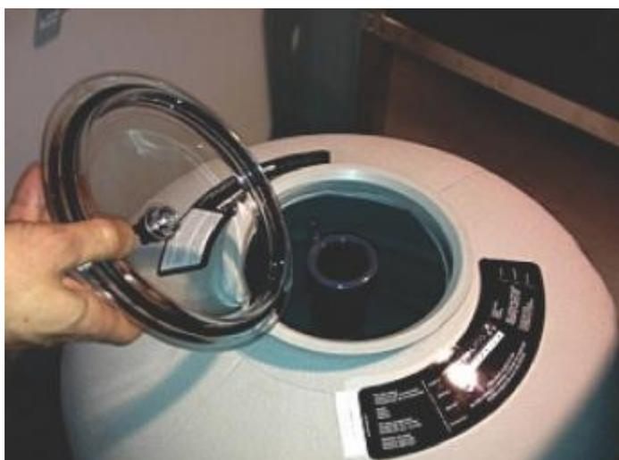
Рисунок 50: Снятие фильтрационной крышки
