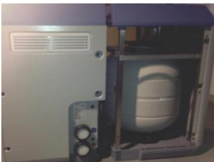
Рисунок 18: Установка фильтрационного модуля вблизи AstralPool MAC
