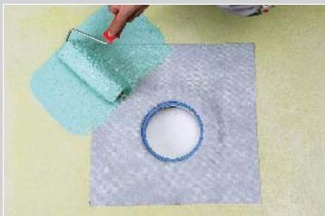
Герметизация сливного трапа пластырем LITOBAND P
