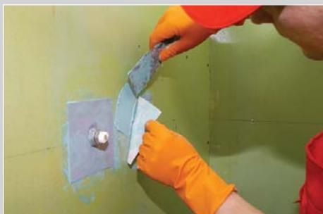
Герметизация выпуска трубы пластырем LITOBAND S
