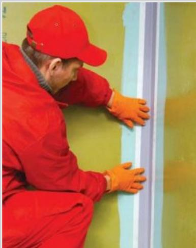
Герметизация стыка "стена-стена" лентой LITOBAND R
