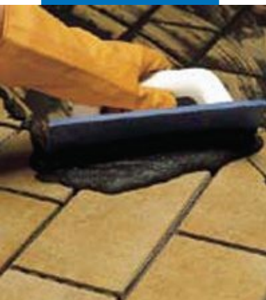
Заполнение швов снаружи помещения в клинкерной плитке с использованием Keracolor GG, смешанным с Fugolastic.
