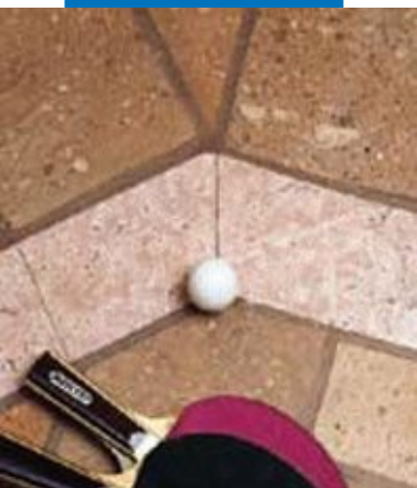
Керамическое напольное покрытие, отполированное без демонтажа, для заполнения швов использовался Keracolor GG, смешанный с Fugolastic
