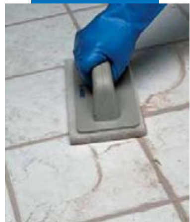
Очистка с помощью панели Scotch-Brite®
