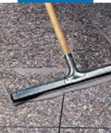
Заполнение швов в гранитных полах резиновой раклей
