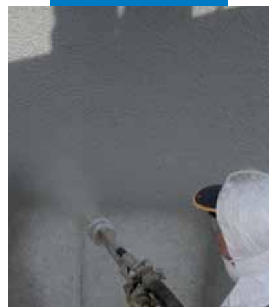
Нанесение Mapelastic на виадук путем распыления
