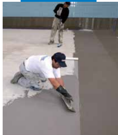
Гидроизоляция бассейна с применением Mapelastic
