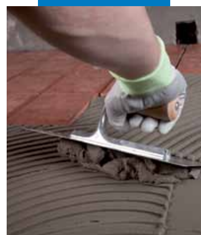
Нанесение Granirapid на гидроизоляцию Mapelastic на террасе
