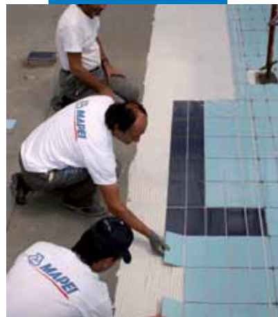
Укладка керамической плитки на Mapelastic в бассейне
