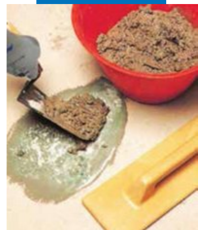
Ремонт пола: нанесение строительного раствора
