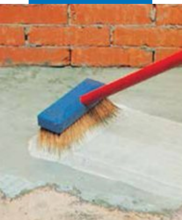
Нанесение цементного раствора с добавлением Planicrete
