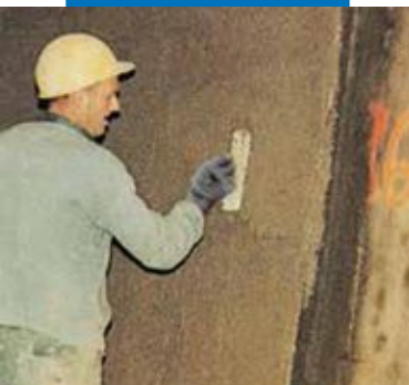
Использование цементной штукатурки с добавлением Planicrete в строительстве автодорожного туннеля в Виль-Мари, Монреаль, Канада
