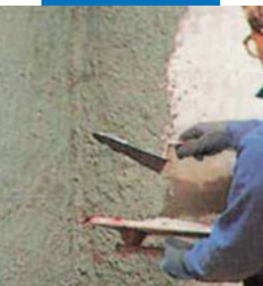
Нанесение адгезионной штукатурки с добавлением Planicrete
