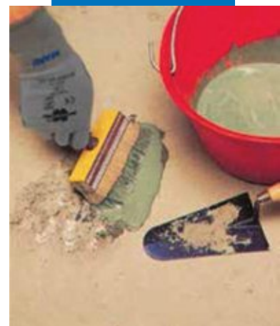
Ремонт пола с нанесением цементного раствора
