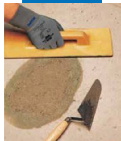
Ремонт пола: заглаживание поверхности
