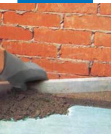
Укладка цементной стяжки с добавлением Planicrete
