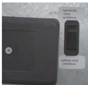
Переключатель режима работы вентилятора
