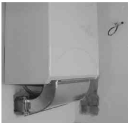
Вид с соседнего помещения
